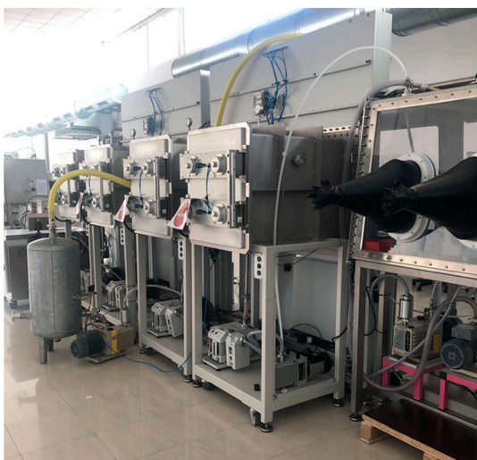
9-Antecámaras de comunicación automatizadas.
